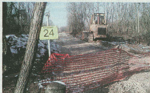
Un'immagine del disboscamento attuato a Castellazzo per far passare le vie d'acqua
