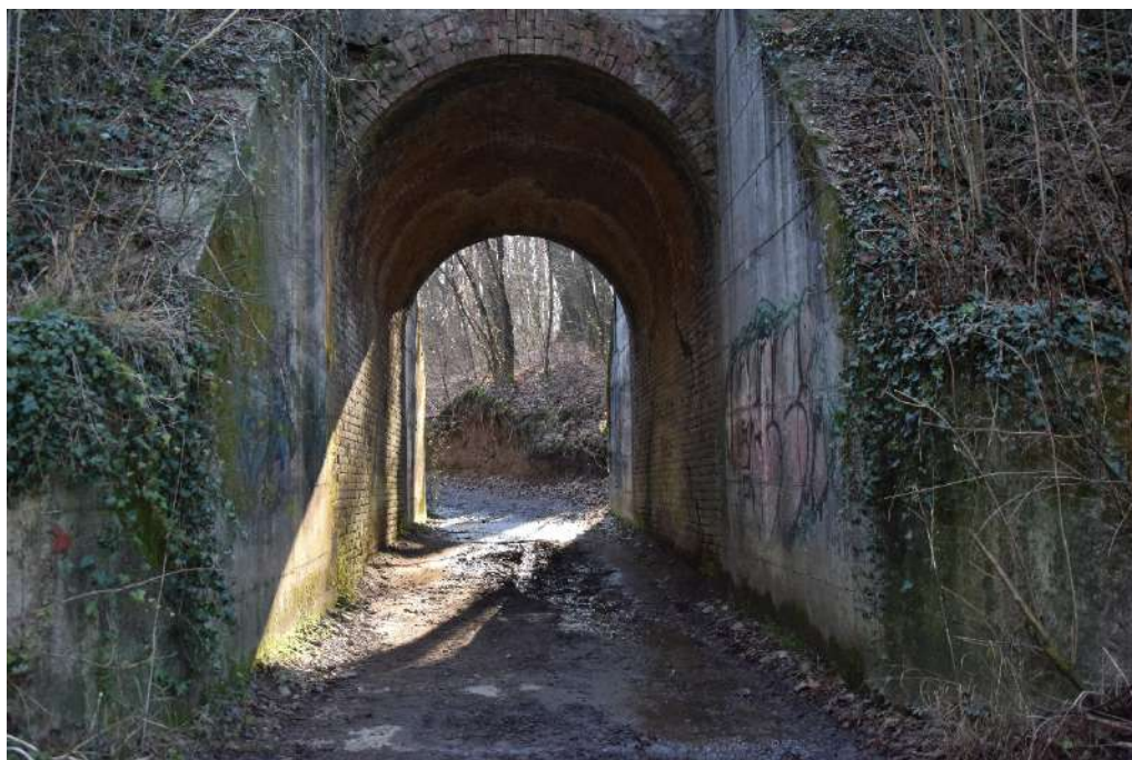
Foto 68 - sottopasso ferroviario fra Fecchio e Varenna
