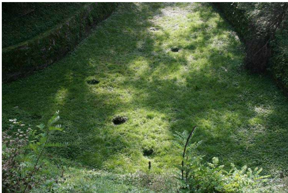
Foto 7 - Tini di fuoriuscita della acque di falda nella testa del Nan
