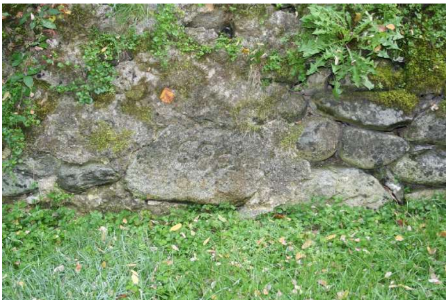
Foto 3 - Data della costruzione del fontanile incisa nelle pietre della muratura
