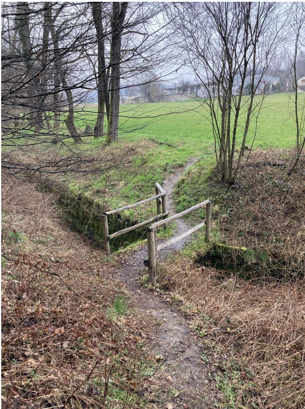
Fotografia 4: Piccolo ponte per attraversare il tratto di Roggia Borromeo canalizzato a nord della Riserva.
